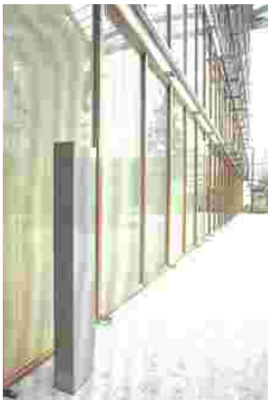
COM.form Technikstele Bewässerungsautomat, Hot Spot, Temperaturfühler
